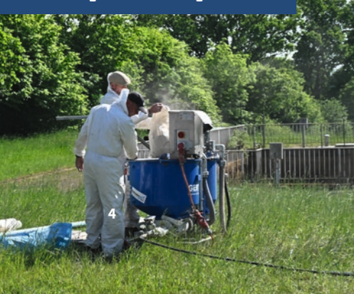
Verfüllung mit zementartigem Material
